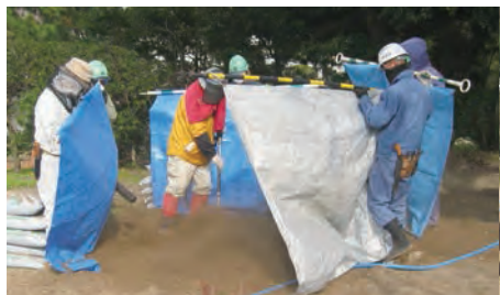
空気で穴を掘ることで根を傷めることが少なくてすむ
