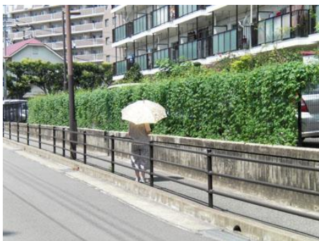
マンションの境界フェンスに 30メートルの緑のカーテンを作りました
