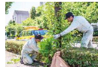
危険箇所の応急作業
