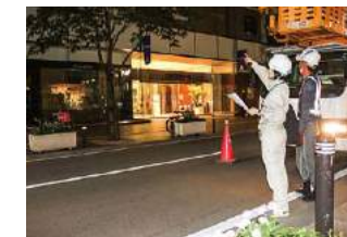
夜間立会の様子
