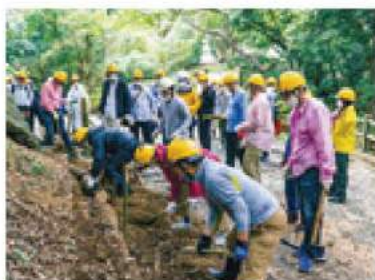
土が遊歩道側に崩れるのを防ぐ土留め
