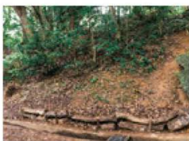
約1時間で完成した土留めの柵
